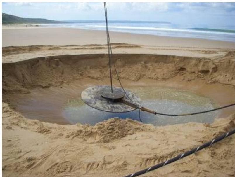
Figura 5. Installazione piastra di terra “earth plate”
