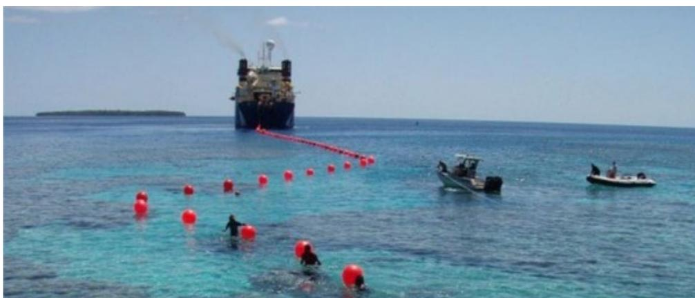
Figura 9. Operazioni di approdo con linea di traino galleggiante.
