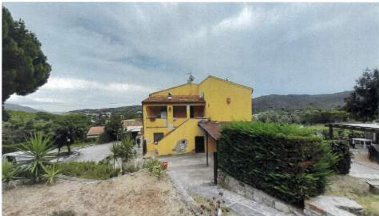
Descrizione: Prospetto lato Nord/Ovest Non sono presenti elementi architettonici di valore, tetto a tegole marsigliesi presenza di una tettoia coperta con tegole canadesi
