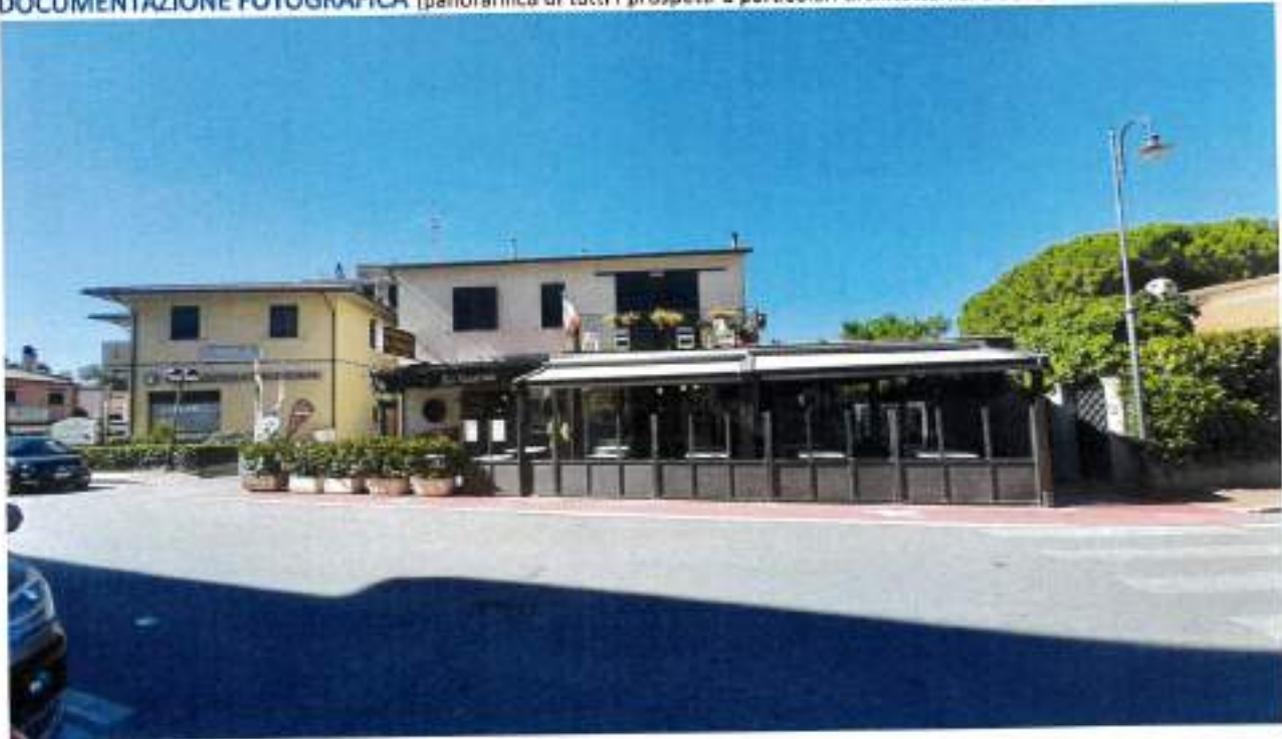
Descrizione: Prospetto lato Nord non sono presenti elementi architettonici di valore oggetto sporgente vi è la presenza di porticati e tettoie moderne che hanno alterato lo stato originale del vecchio fabbricato
