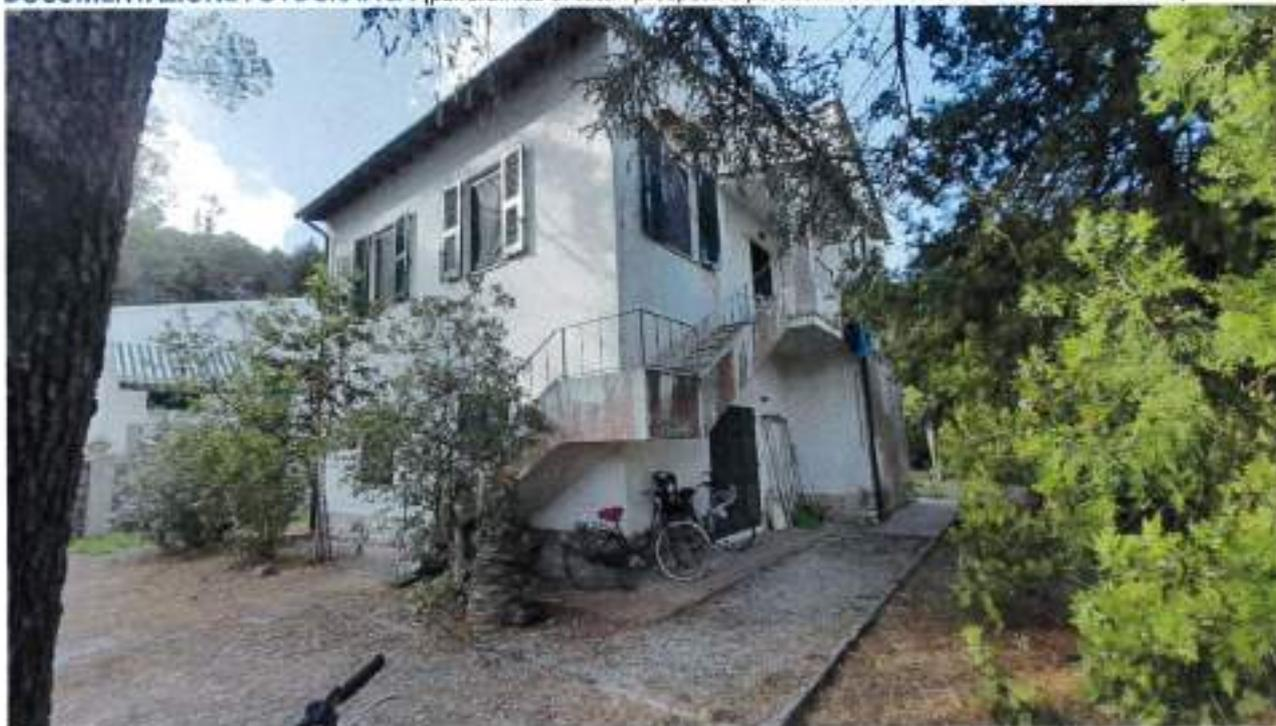
Descrizione: Prospetto lato Nord e Est presenza di aperture incongrue, chiusura di una porta prospetto Nord aggetto realizzato con travetti in legno, scala non tipicamente "elbana" in aggetto e con ringhiera, marcapiano realizzato in pietra non locale
