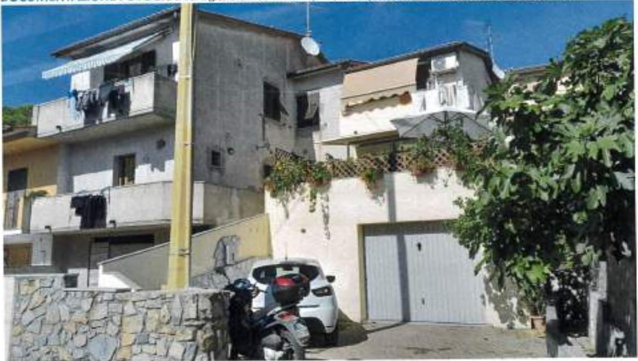
Descrizione: Prospetto lato Ovest l'edificio è stato ristrutturato, presenta balconi e aggetti in C.A. Al piano terra è presente un garage con ampia porta in metallo
