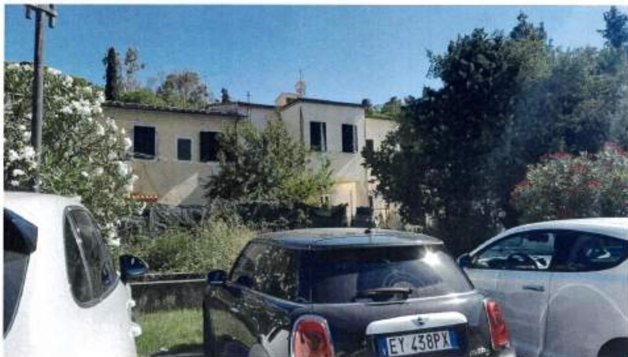
Prospetto Sud ampliamento del piano primo realizzato con copertura piana in aggetto rispetto alla pianta originale del fabbricato
