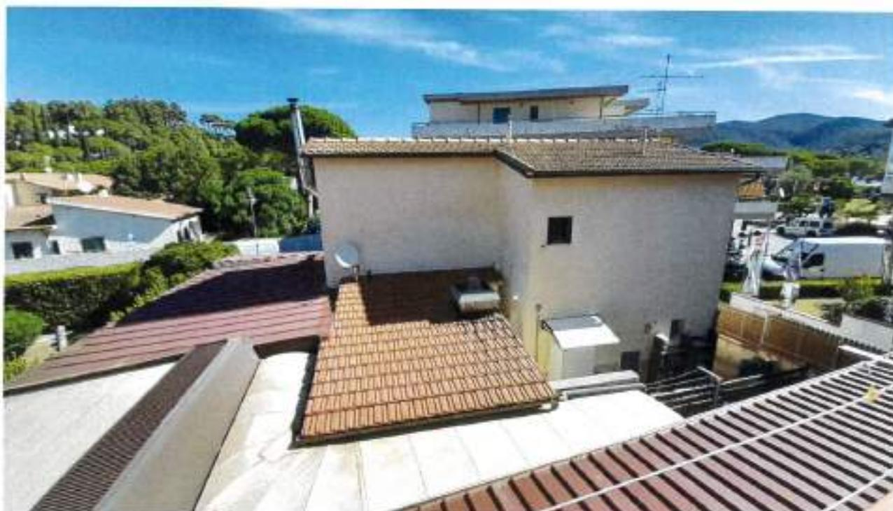
Prospetto Sud presenza di tetto con aggetto sporgente, come si evince dalle foto il fabbricato è stato ampiamente modificato, con la presenza di un ampliamento e diverse tettoie realizzate con materiali moderni
