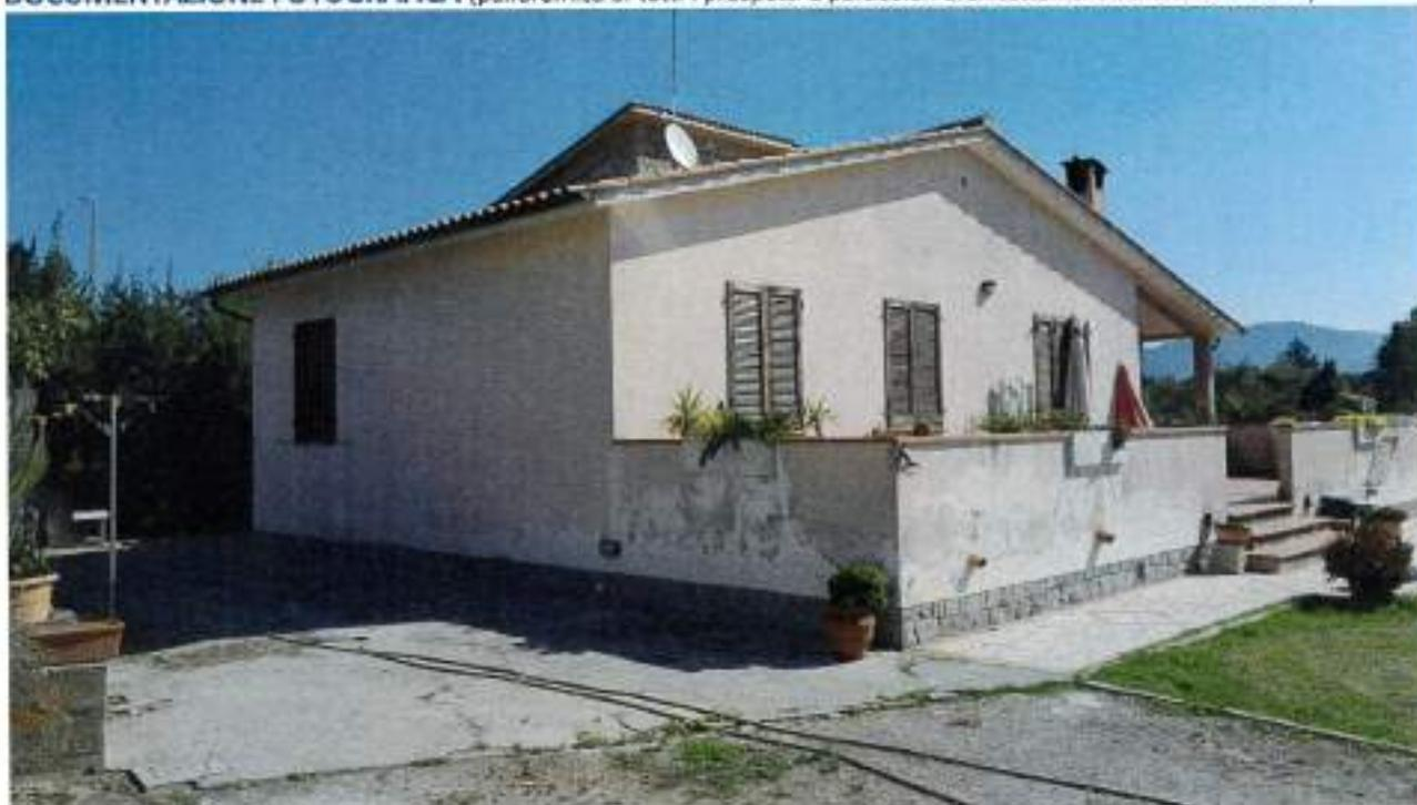
Descrizione: Prospetto lato Ovest e Ovest fabbricato ristrutturato, la facciate si presentano come quelle di una moderna villetta con finiture in cotto e granito, di impostazione moderna gli aggetti sono in cemento armato
