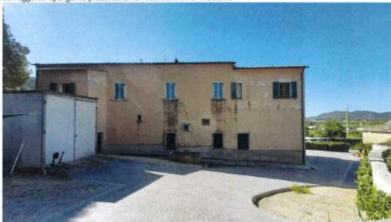
Descrizione: Prospetto lato Nord presenza di un marcapiano , presenza di un'ampliamento tetto con aggetto sporgente
