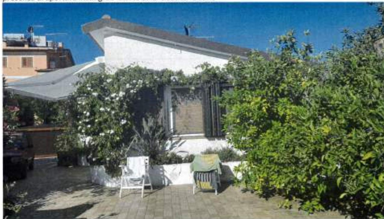
:Prospetto lato Est non sono presenti elementi architettonici di valore, presenza di aperture molto ampie incongrue con lo stile classico elbano, presenza sulla copertura di scossaline in rame
