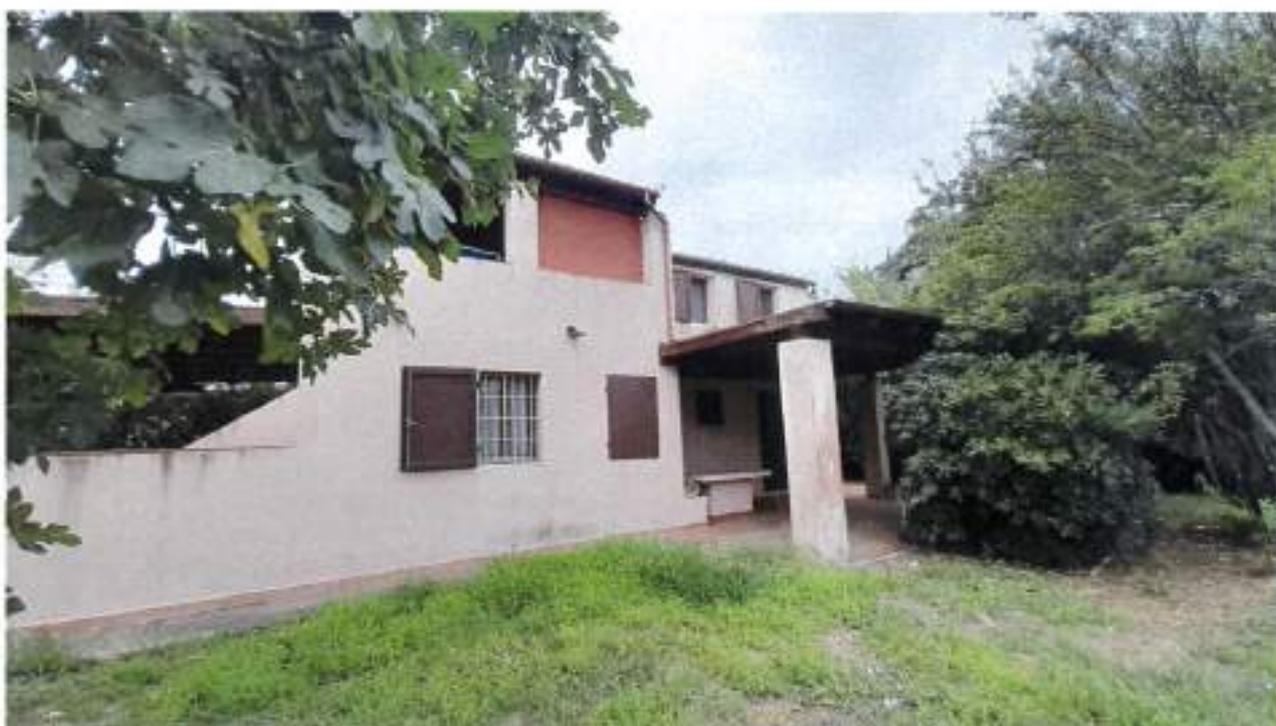
:Prospetto lato Nord, non sono presenti elementi architettonici di valore è presente una finestra incoerente con le altre sotto la tettoia, tutte le tettoie sono realizzate con tegole candesi
