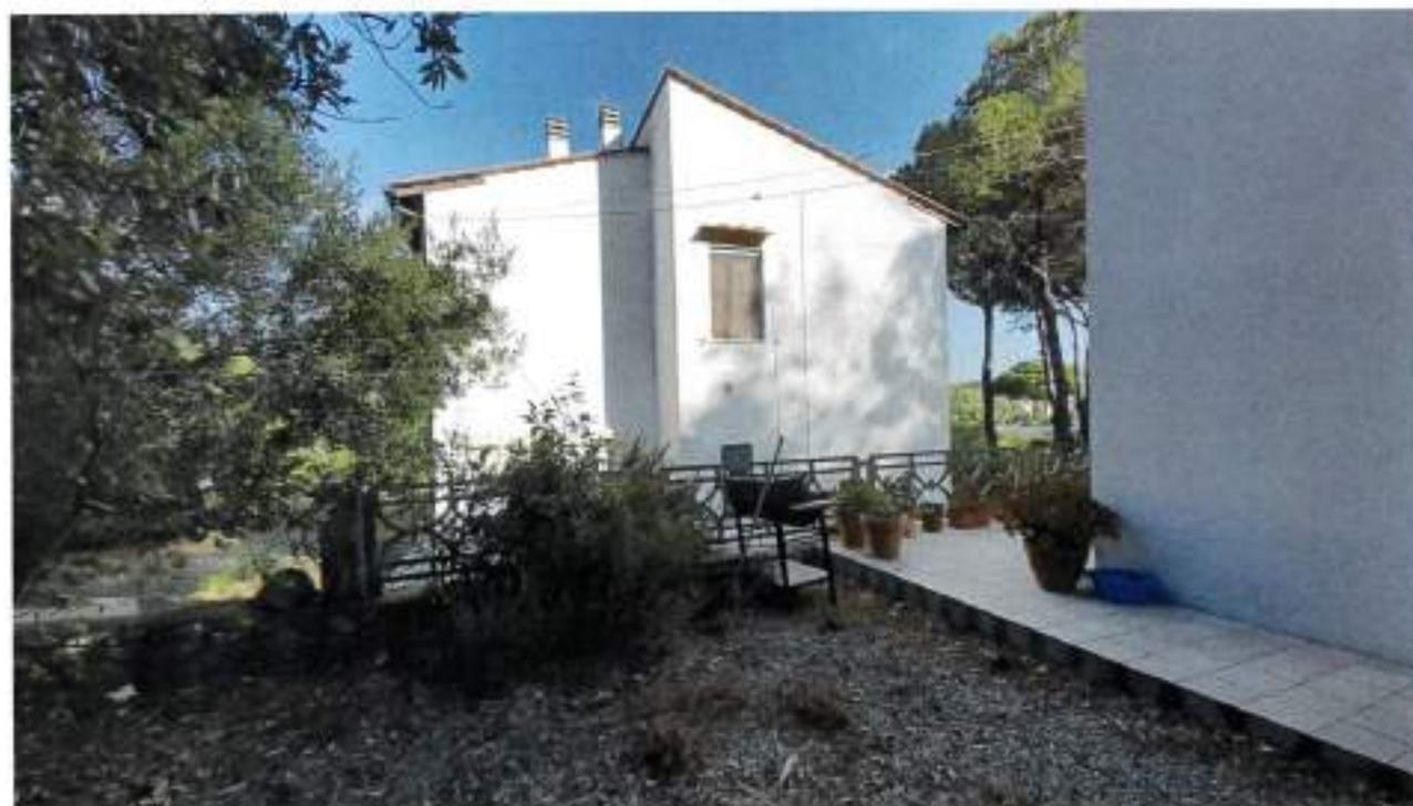
Prospetto lato Sud e Nord ovest, eccessiva pendenza del tetto, aggetti realizzati con travetti in legno
