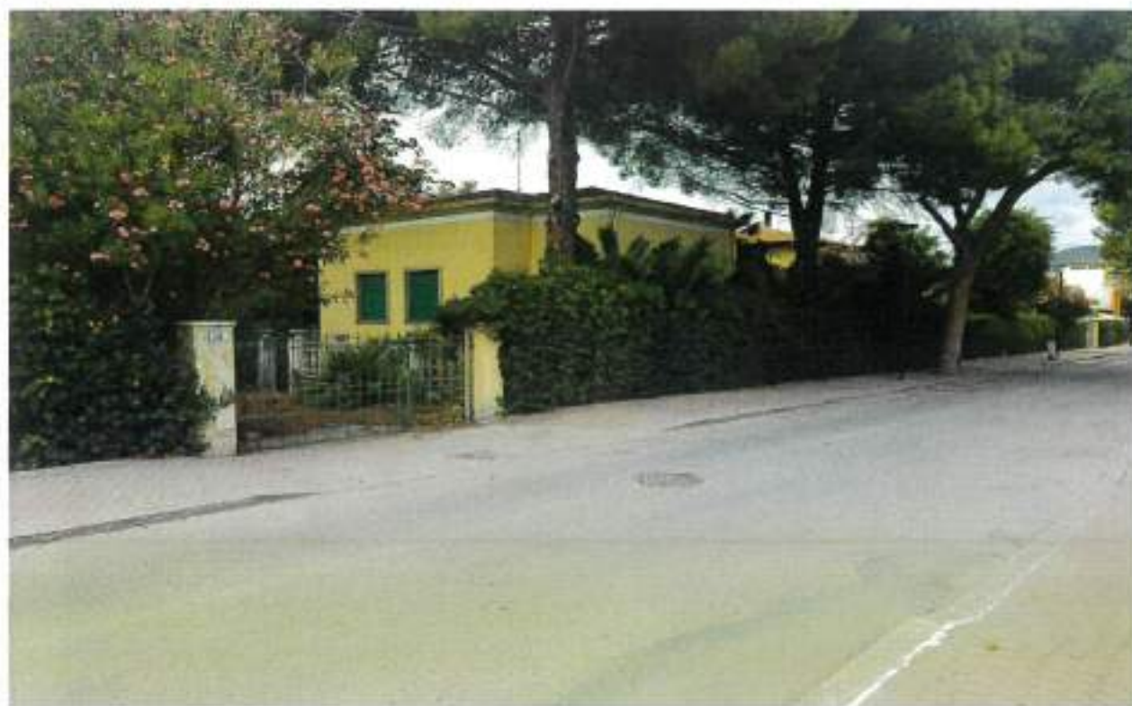
Descrizione: - Vista lato NORD - OVEST
