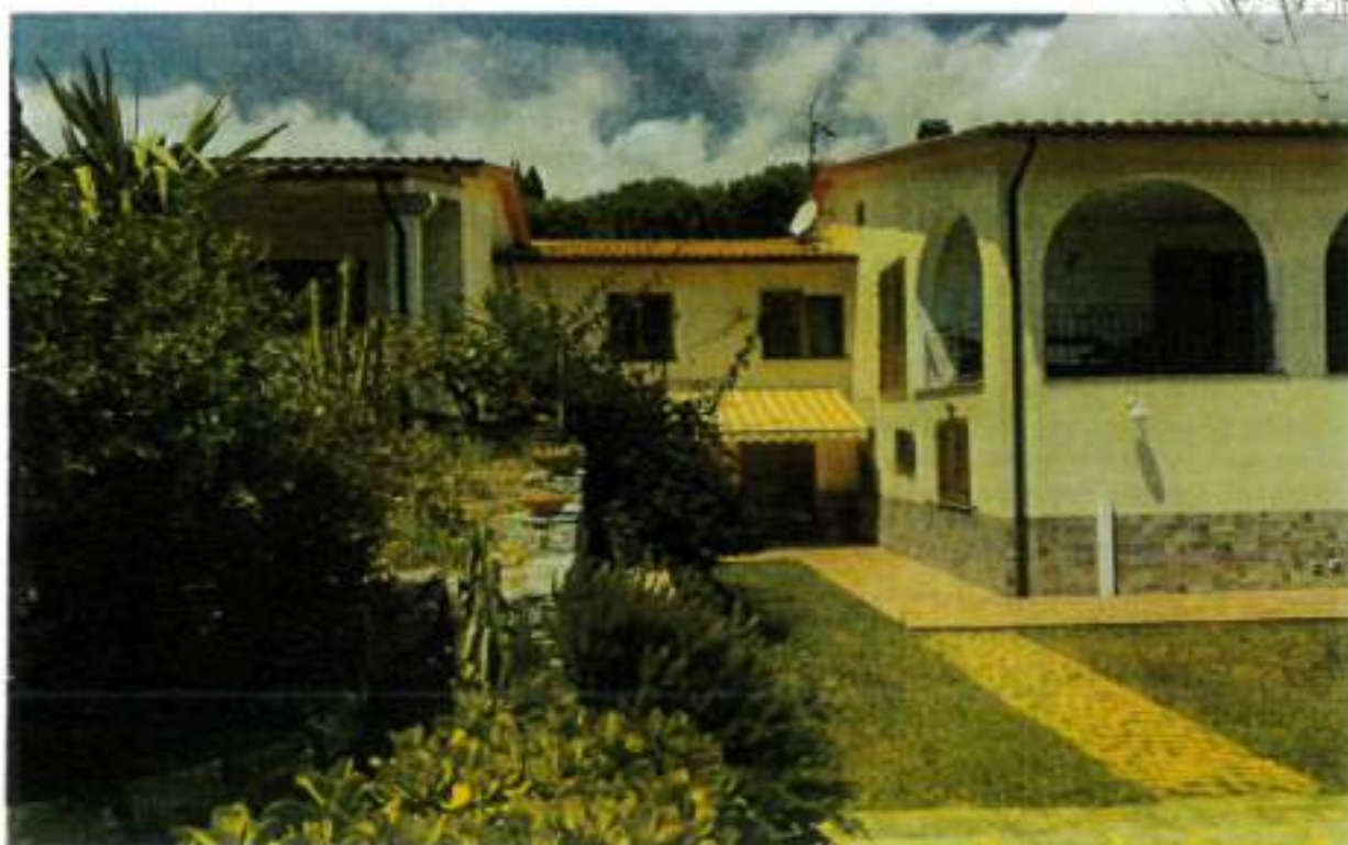
Descrizione: Vista SUD
