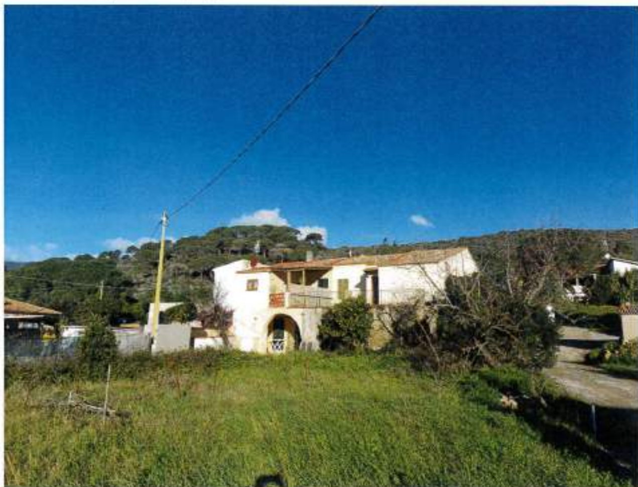
Descrizione: Vista panoramica prospetto Sud
