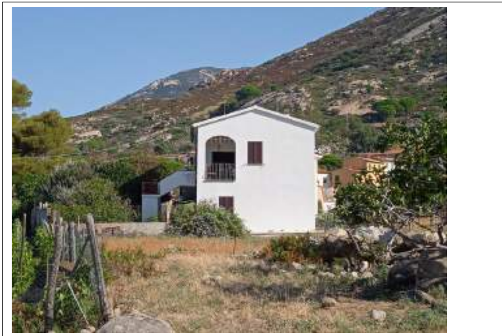
Descrizione: FOTO 2 Prospetto lato sud
