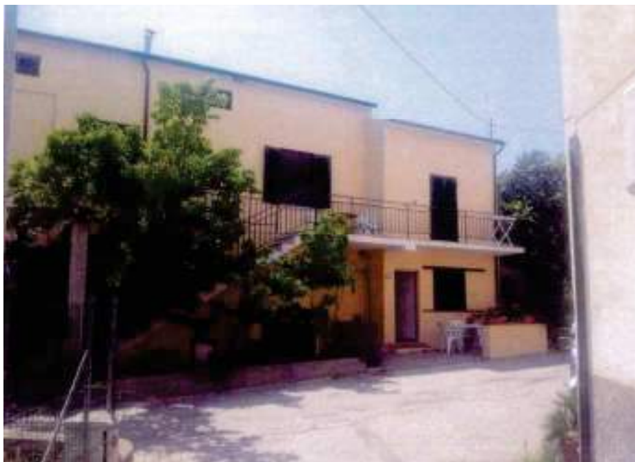
Descrizione: LATO STRADA
