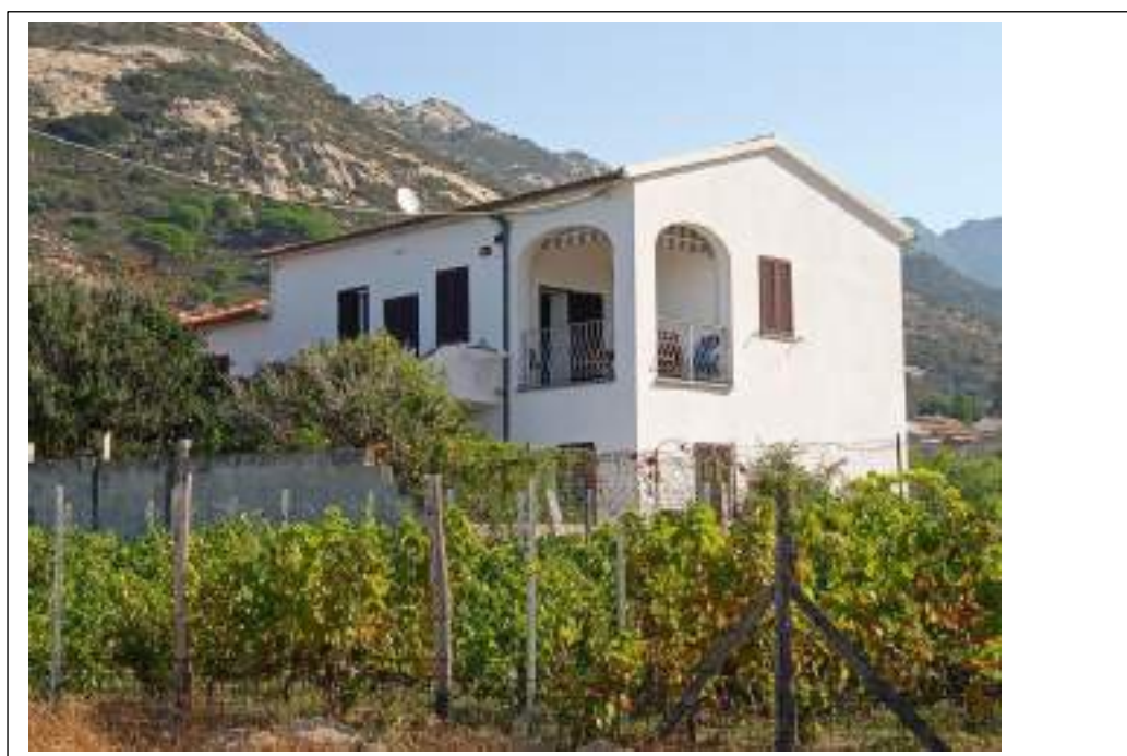
Descrizione: FOTO 1 Prospetto lato ovest
