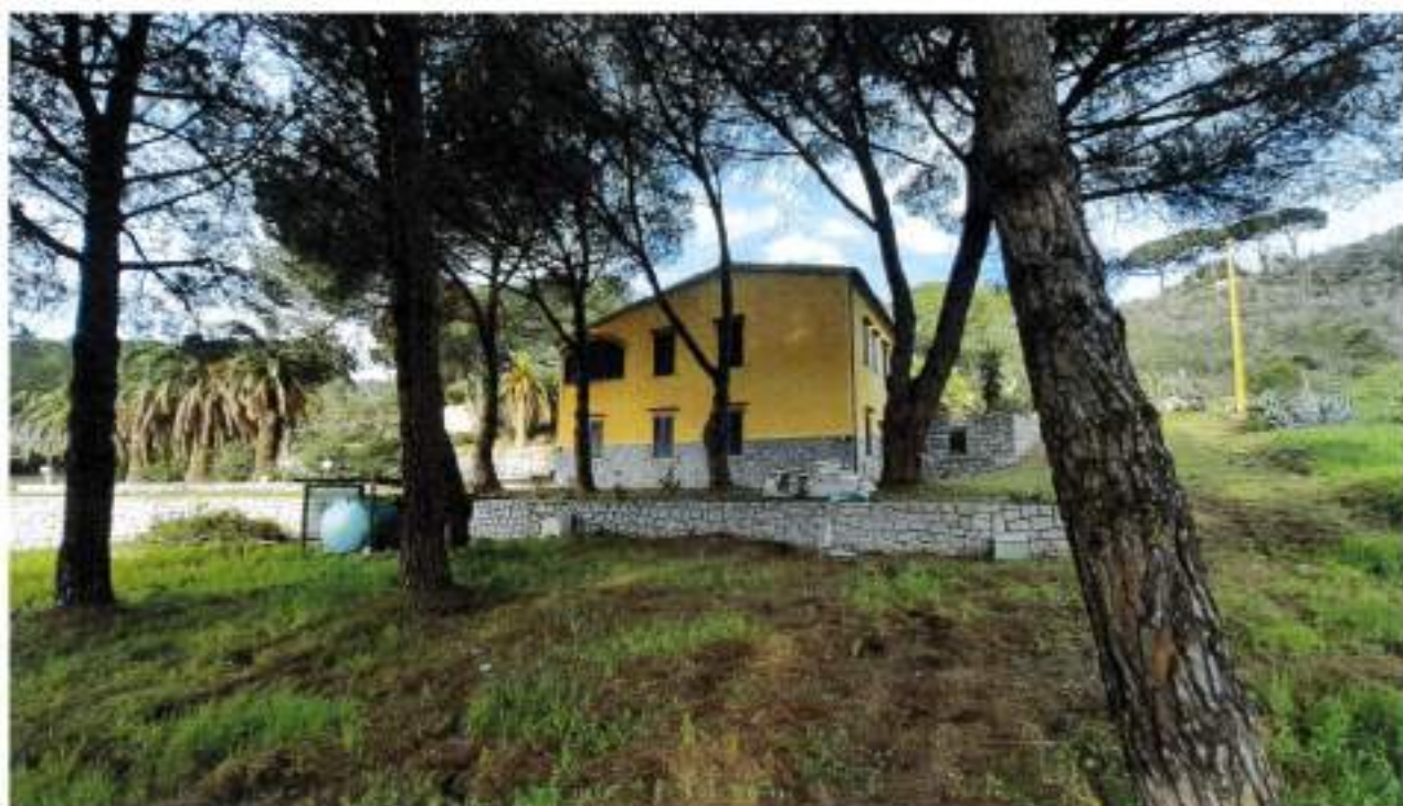
Descrizione: Vista panoramica prospetto Sud
