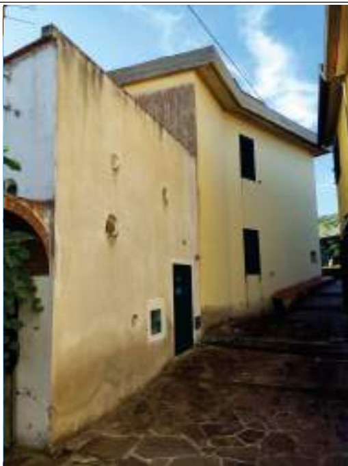
Descrizione: Foto di prospetto, dal retro dell'abitazione
