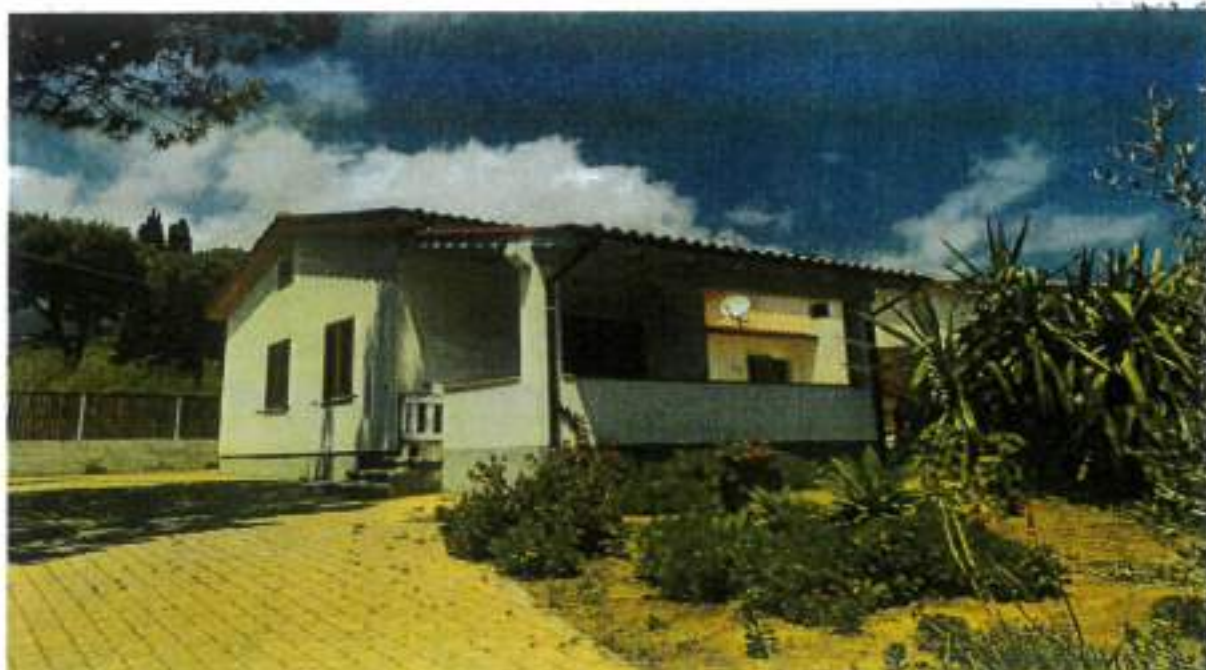
Descrizione: LATO SUD-OVEST
