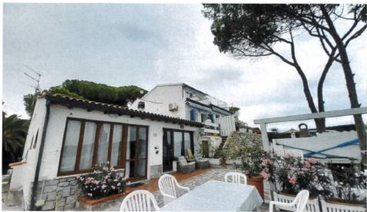
Descrizione: Prospetto lato Ovest
