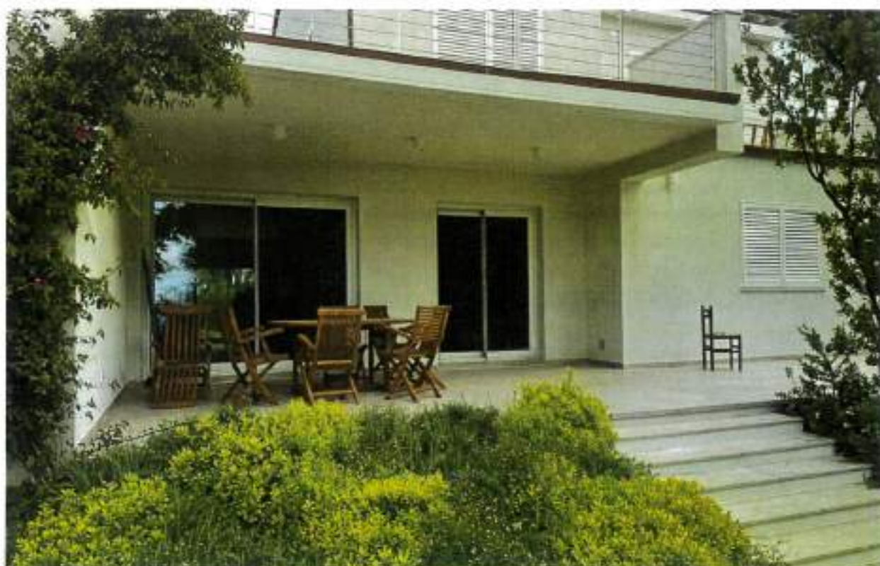
Descrizione: Vista SUD
