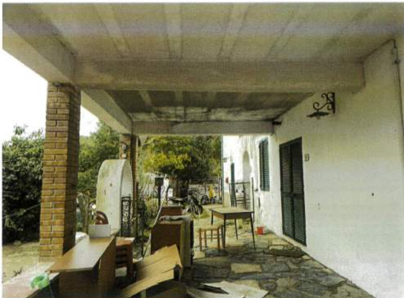
Descrizione: - Vista da portico
