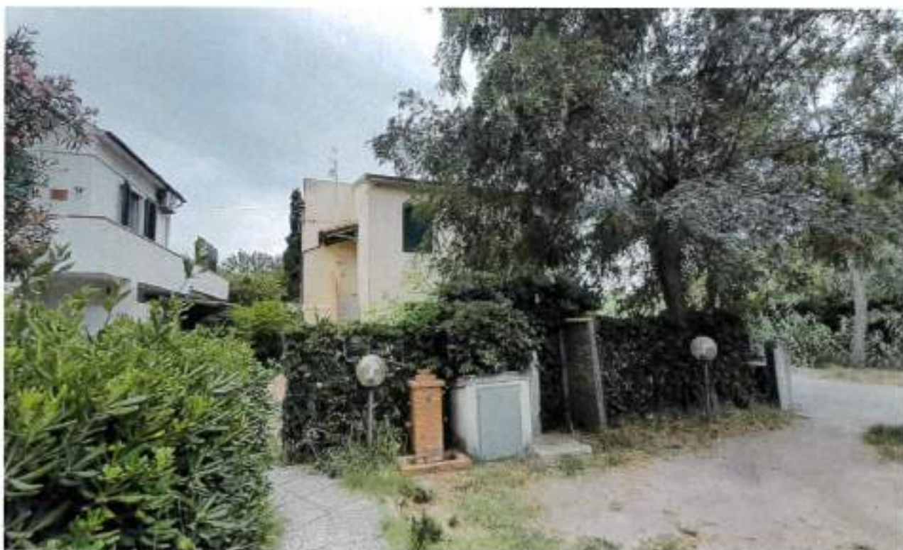
Descrizione: Prospetto lato Ovest
