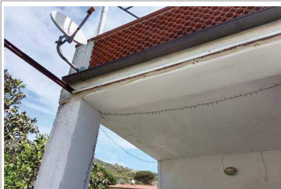
Descrizione: particolare struttura portico; si nota come sia stata realizzata una classica struttura in C.A.
