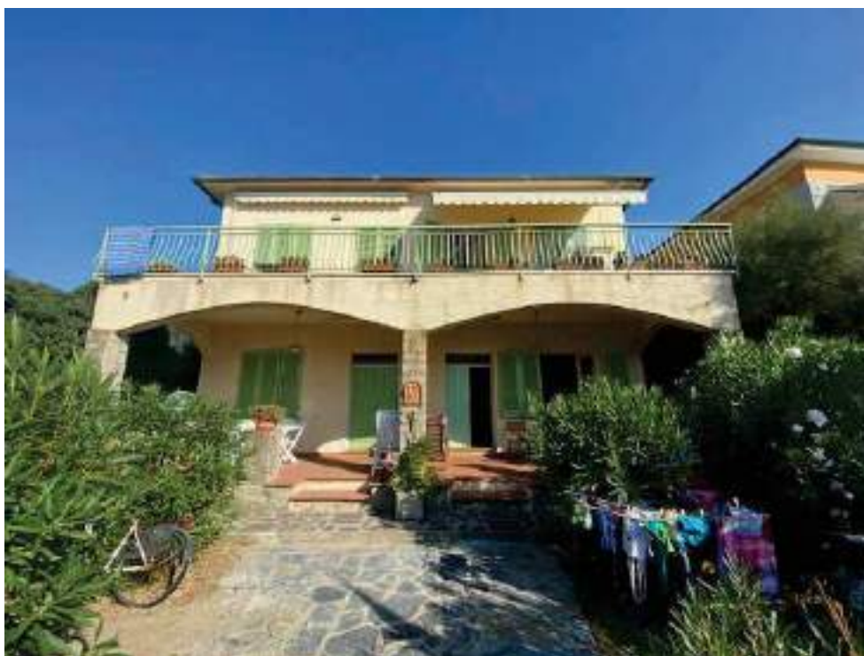
Descrizione: prospetto principale (Sud)
