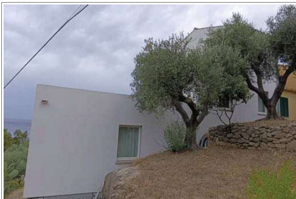
Descrizione: punto di ripresa della facciata tergale
