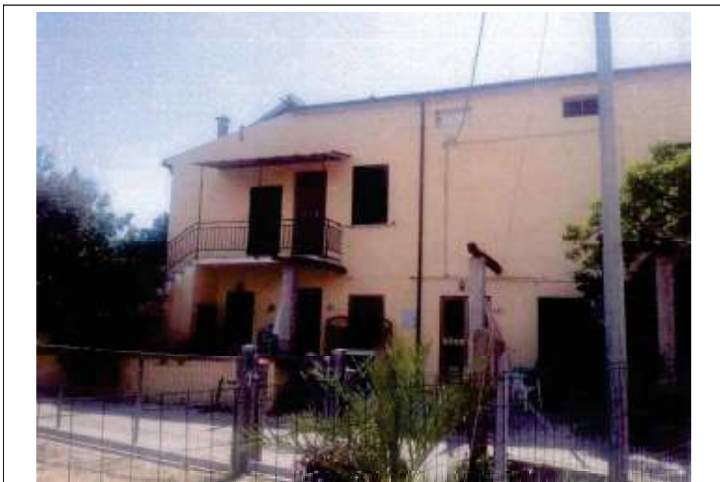
Descrizione: LATO STRADA
