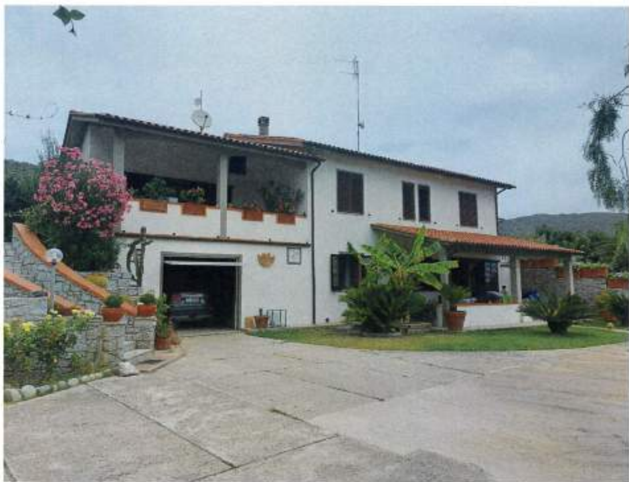
Descrizione: Vista panoramica prospetto Sud
