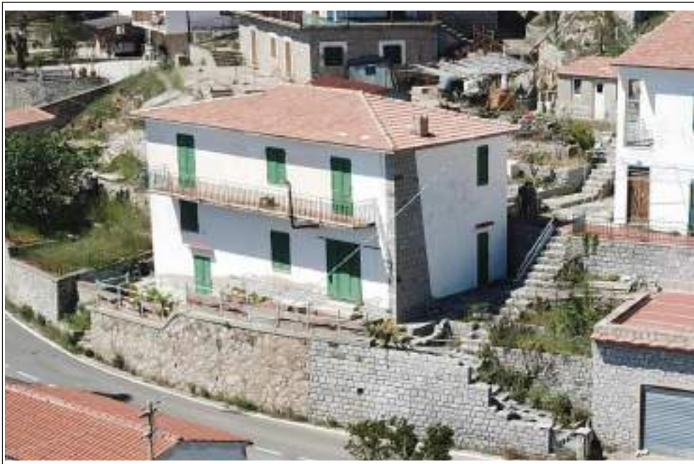
Descrizione: punto di ripresa della facciata principale lato Sud-Est e della facciata Nord Est; mostra l'unica porzione di paramento in muratura con pietra di granito a facciavista
