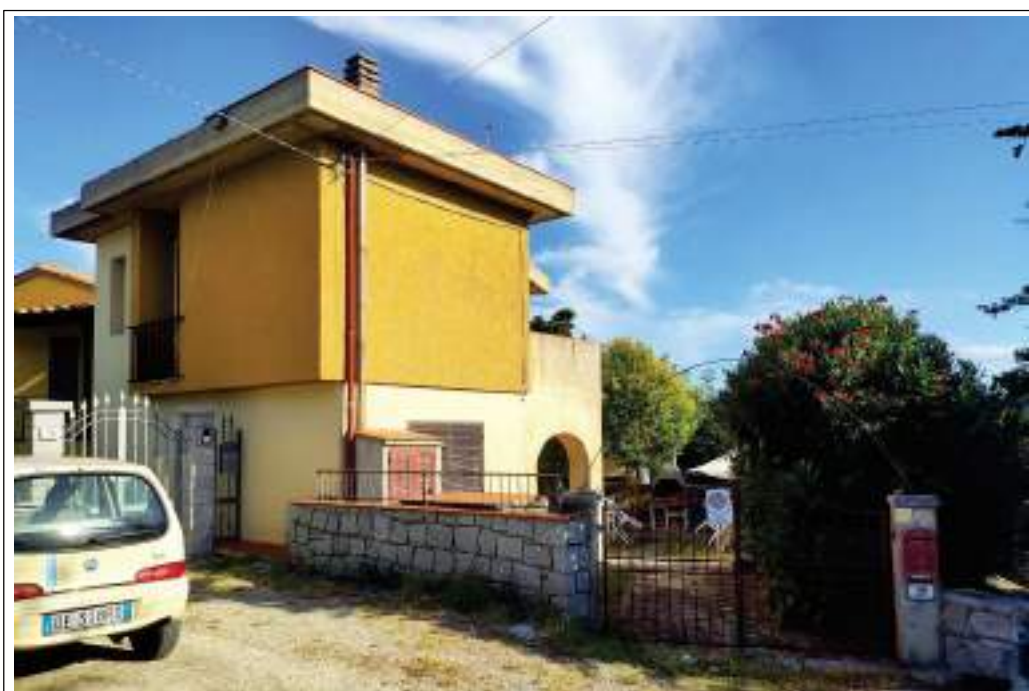
Descrizione: Foto di prospetto, da strada
