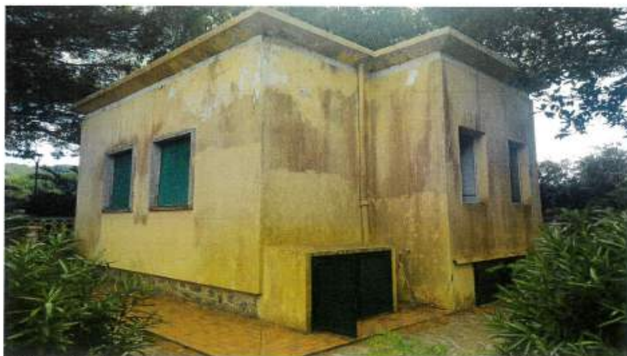
Descrizione: - Vista lato NORD-EST
