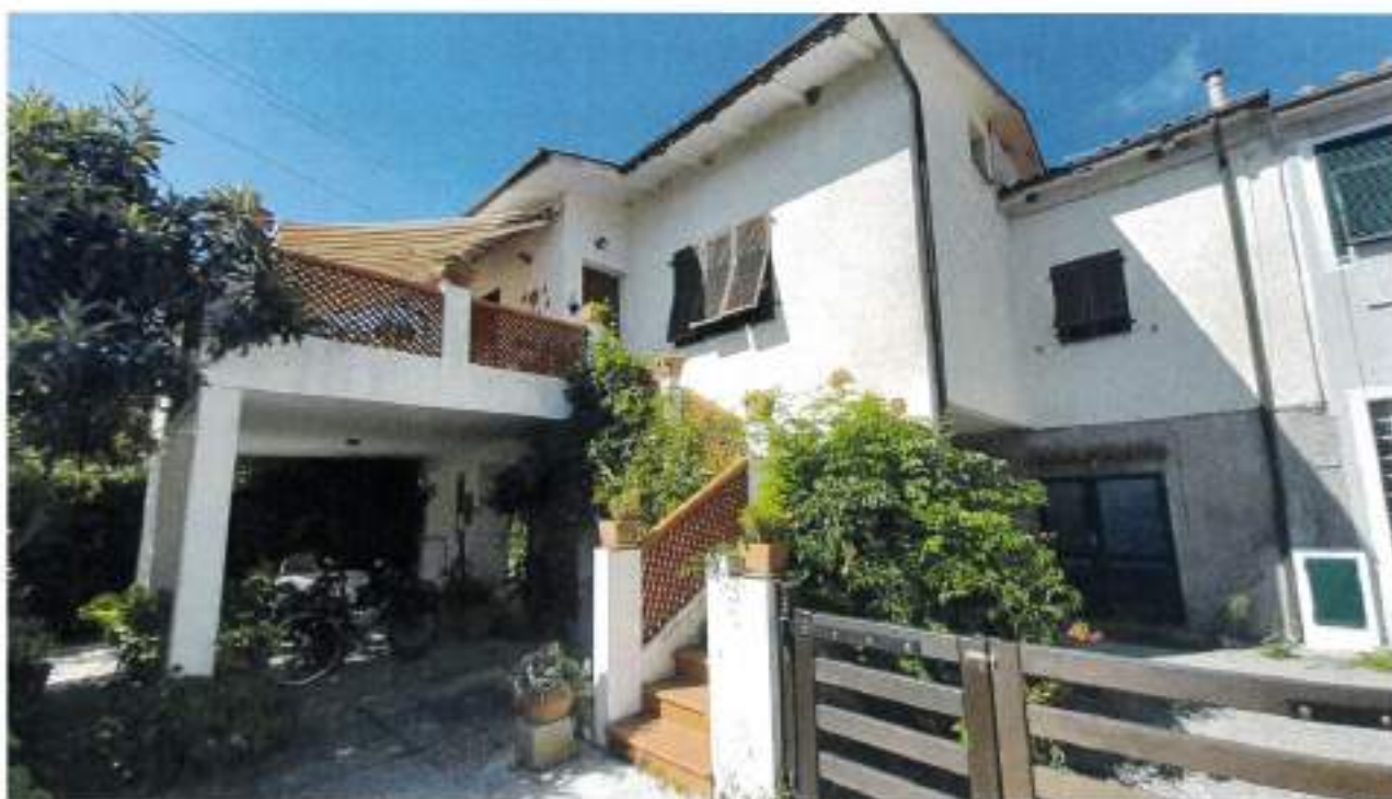
Descrizione: prospetto Est non sono presenti elementi architettonici di valore, aggetti in c.a. molto sporgenti presenza di ampia terrazza con finitura moderna
