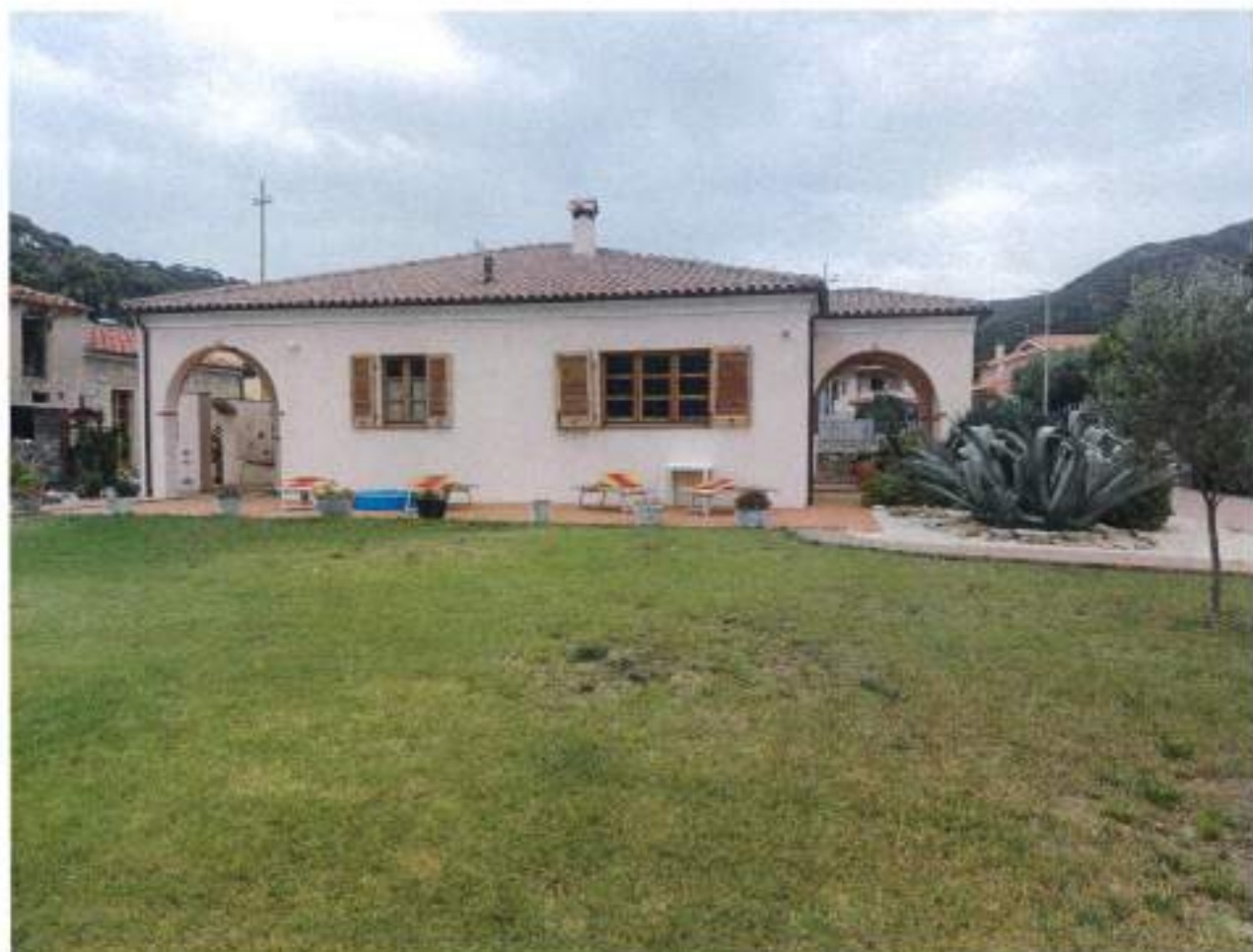
Descrizione: Prospetto lato Ovest.
