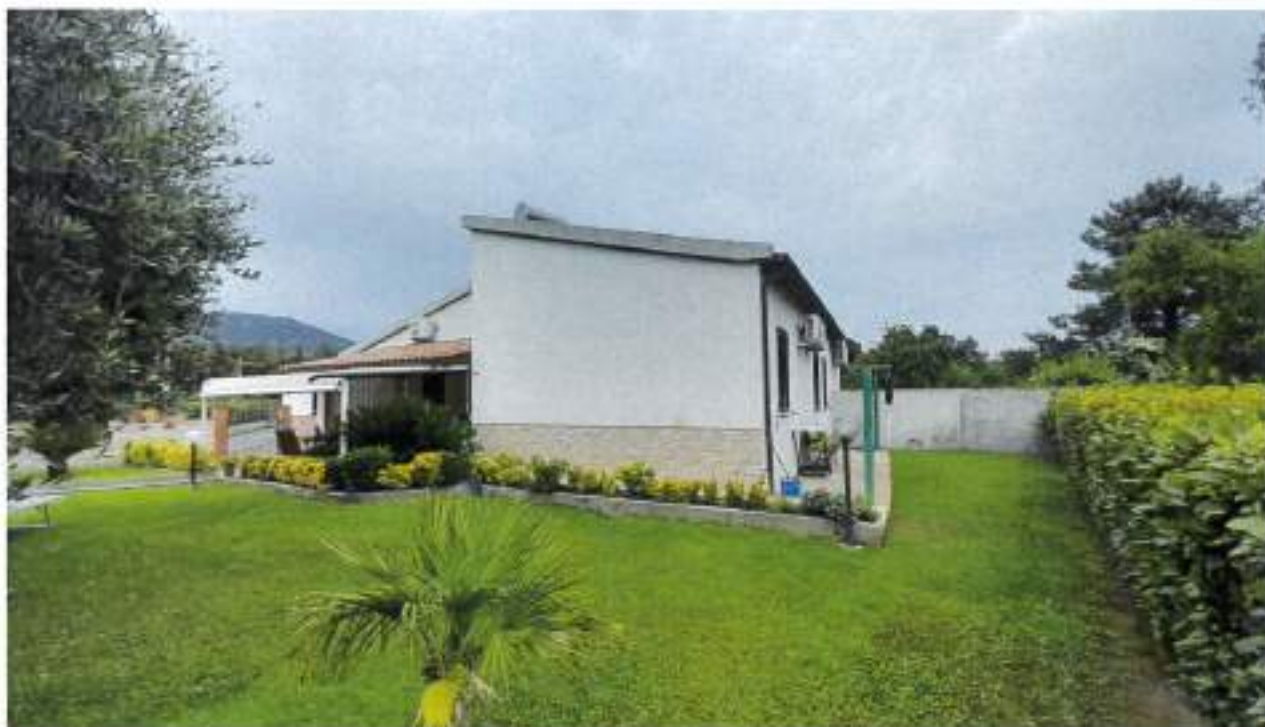
Descrizione: prospetto Sud-Est
