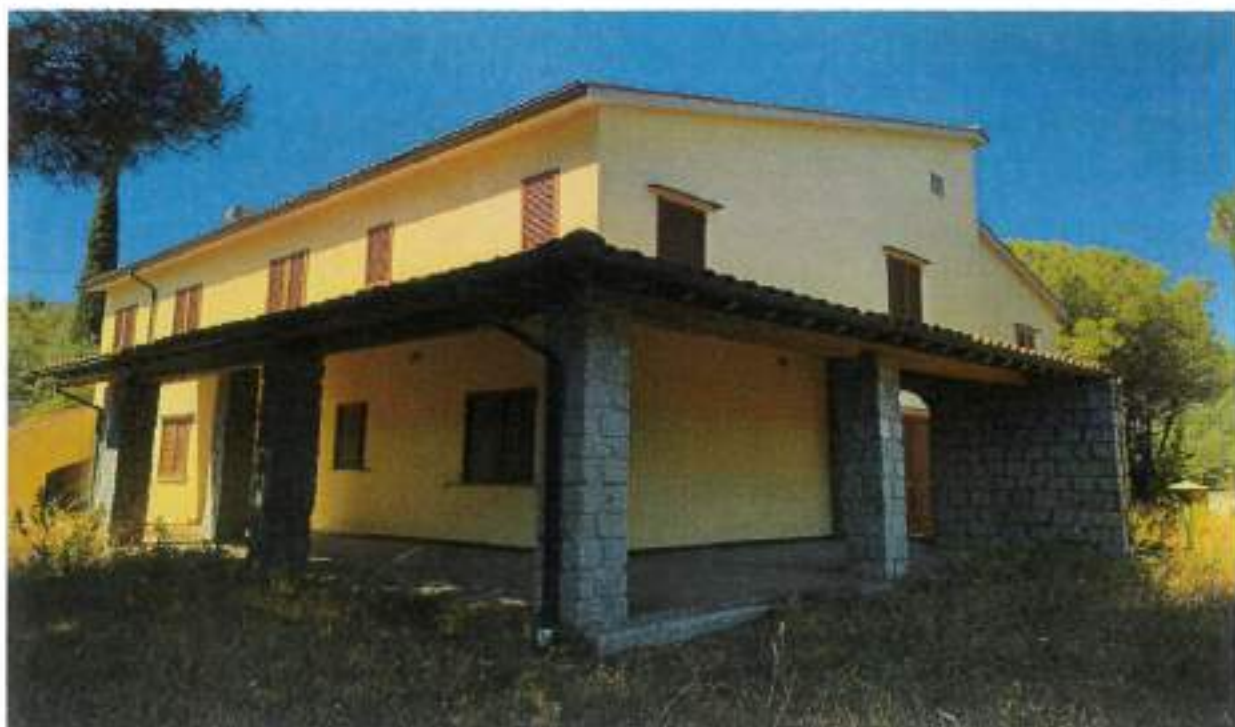
Descrizione: Vista lato NORD-EST
