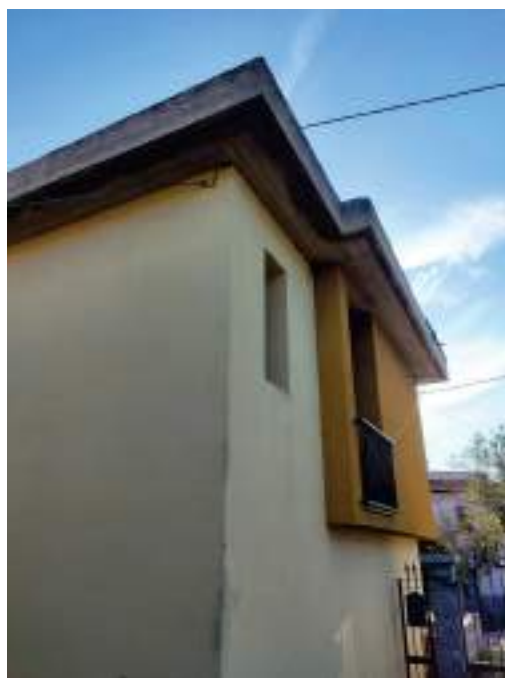
Descrizione: Foto di dettaglio della grondaia
