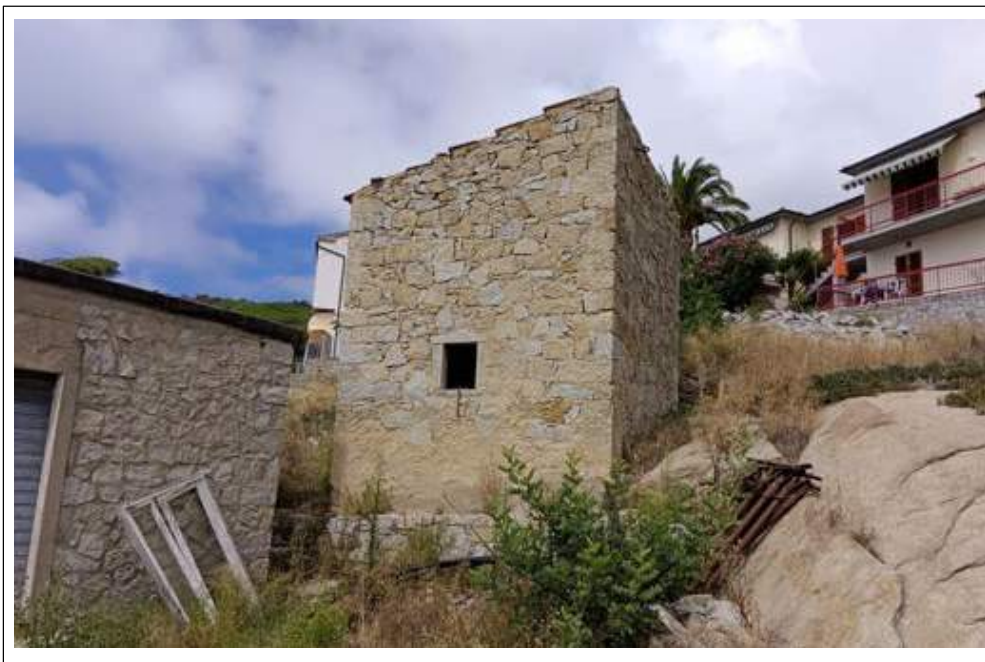
Descrizione: punto di ripresa lato Ovest;
