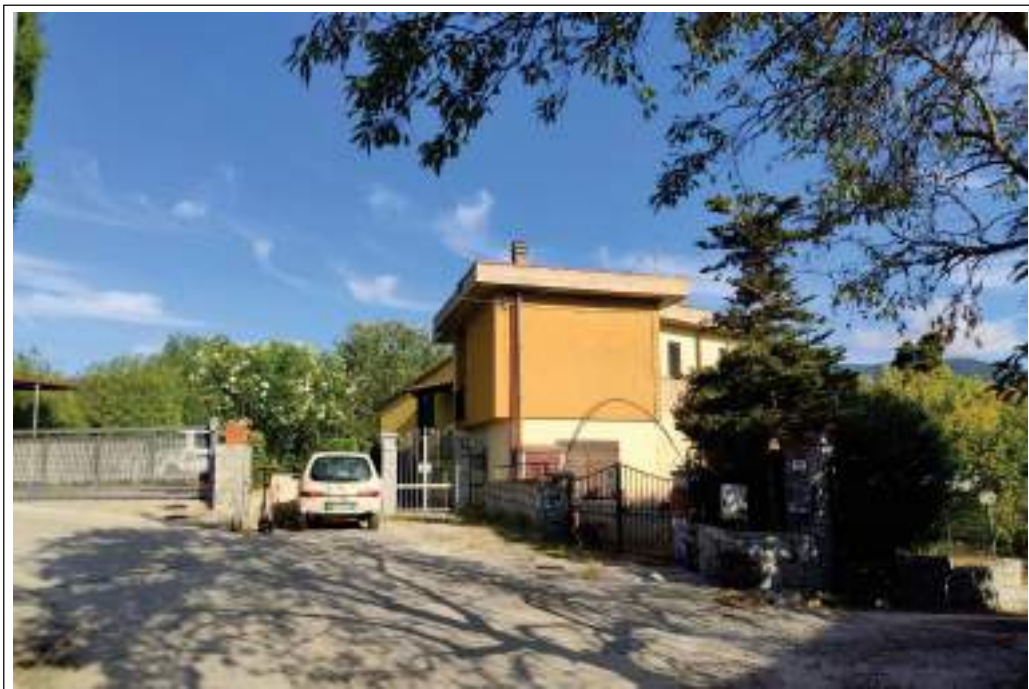
Descrizione: Foto di prospetto, da strada
