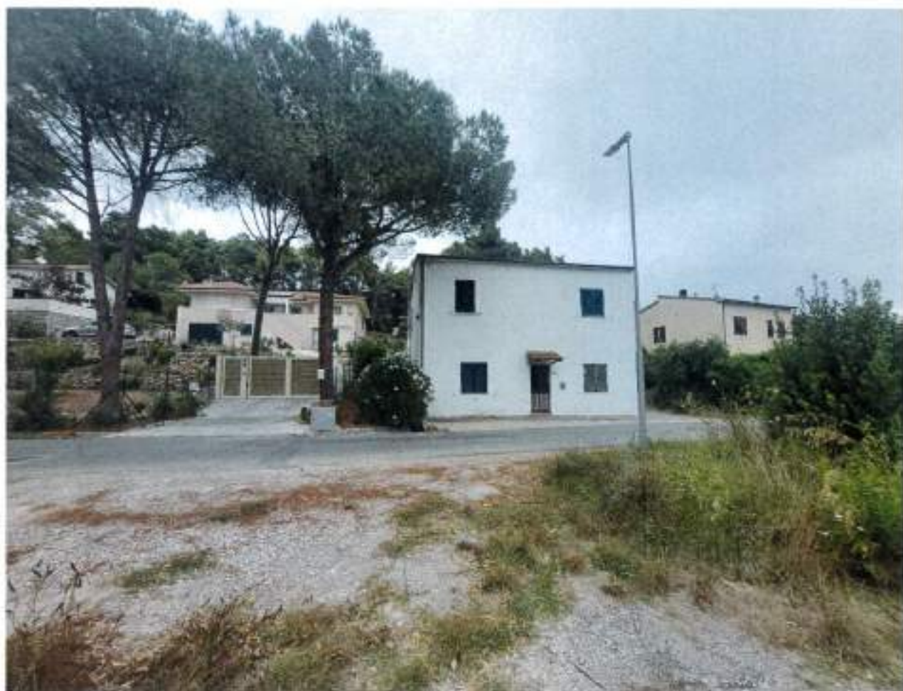
Descrizione: Vista panoramica prospetto principale
