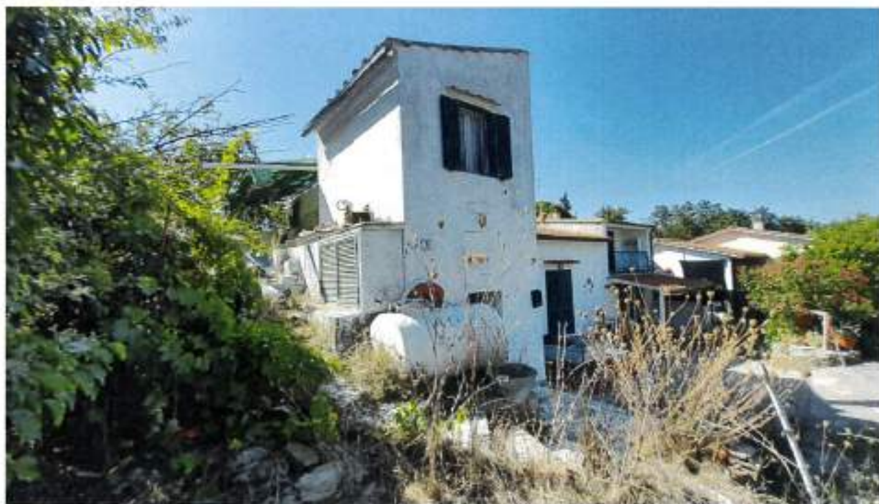
Descrizione: prospetto lato Sud e Est non sono presenti elementi architettonici di valore, sono presenti diverse superfetazioni ( tettoia- casotti ), aggetto non sporgente sul lato Est
