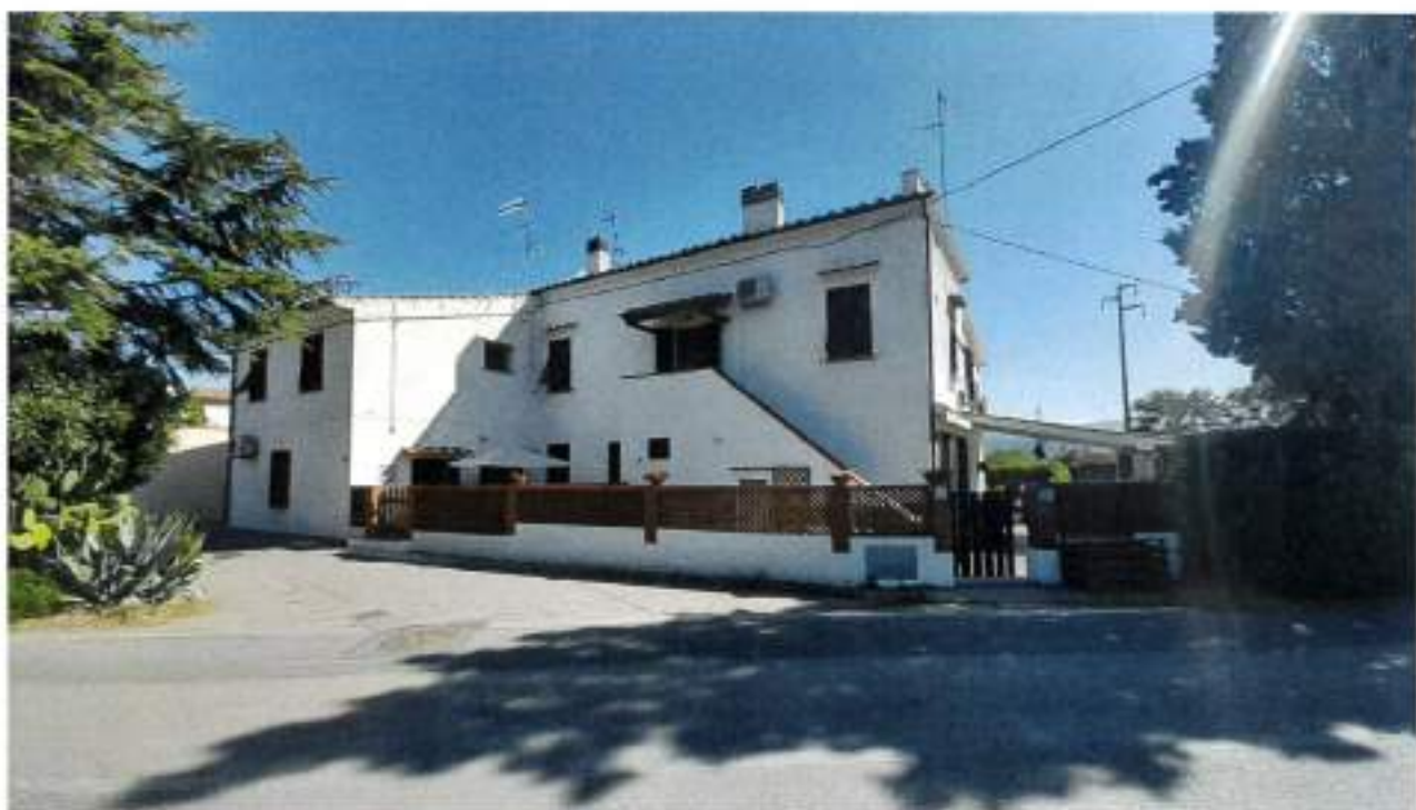
Descrizione: prospetto Ovest e Sud, su una parte della copertura è presente l'imperiale, presenza porticato in c.a.
