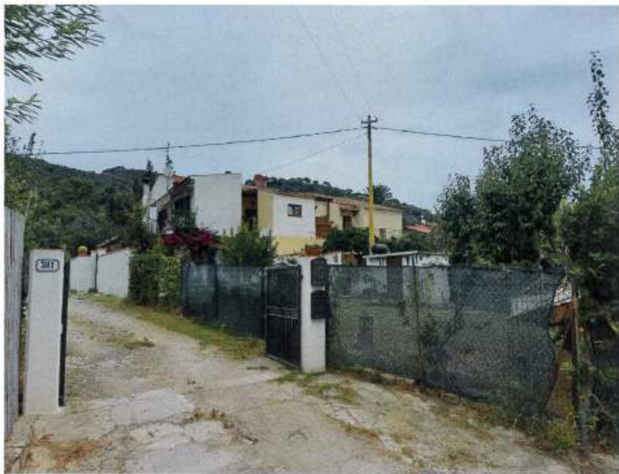
Descrizione: Vista panoramica prospetti Sud ed Ovest
