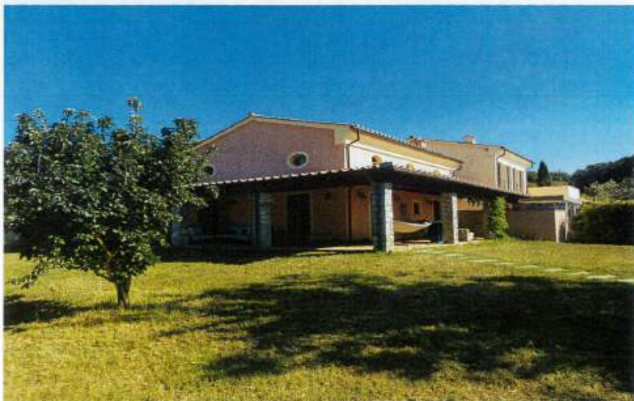
Descrizione: - Vista lato SUD - OVEST
