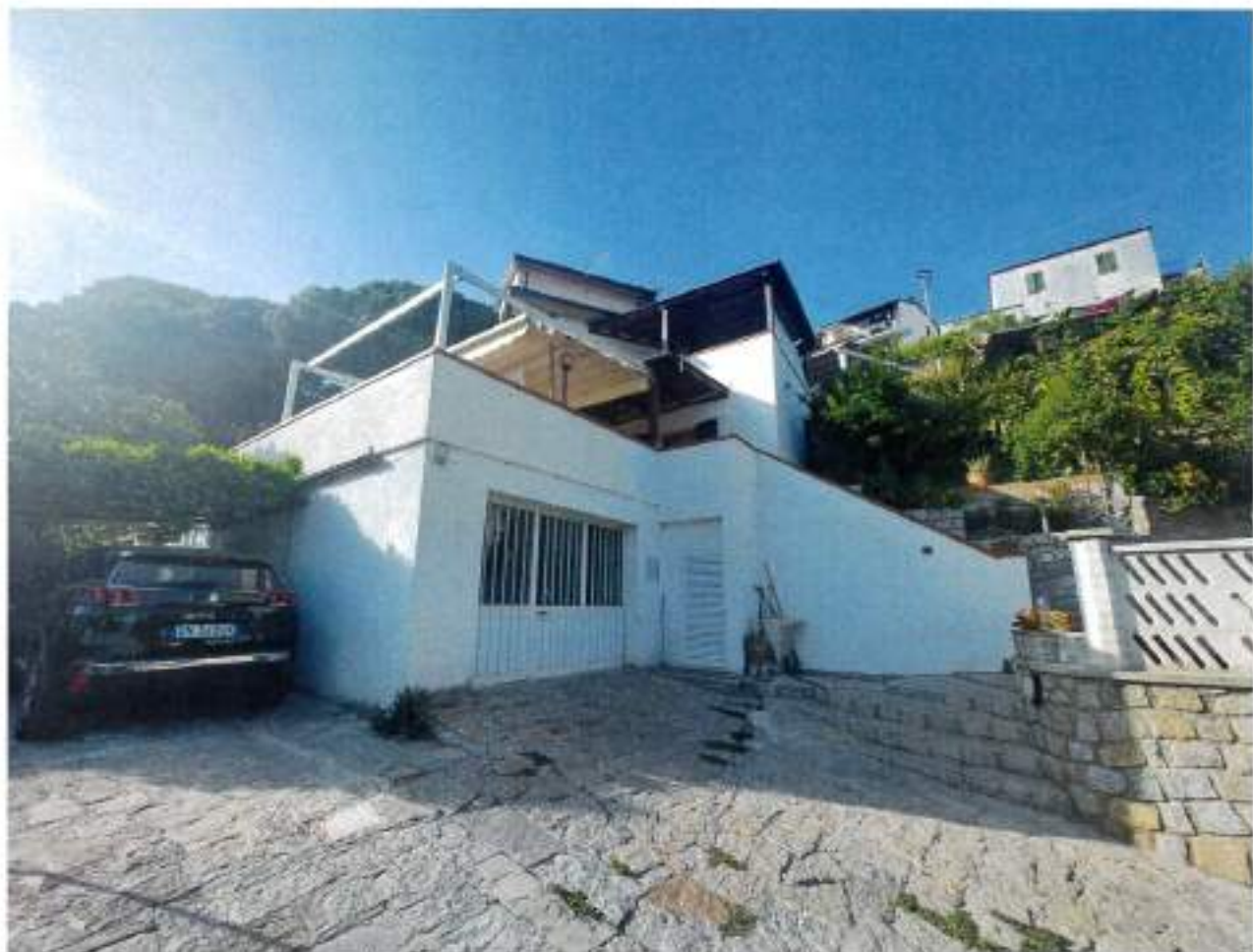
Descrizione: Prospetto lato Sud-Est
