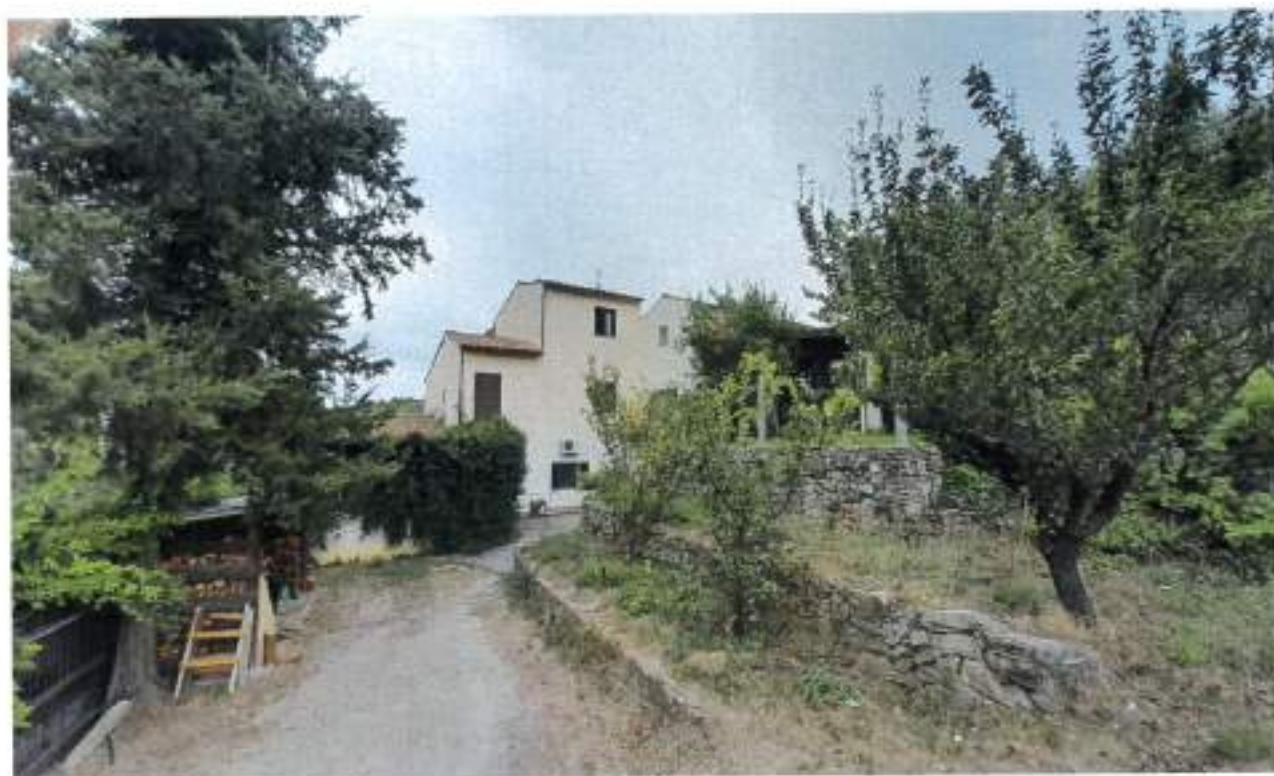
Descrizione: Vista panoramica prospetto Ovest.
