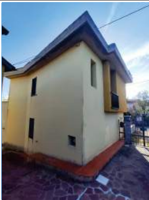
Descrizione: Foto di prospetto, dal retro dell'abitazione
