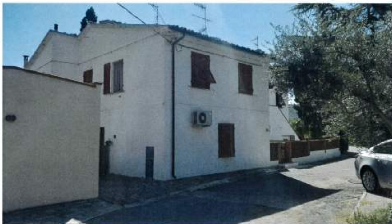
Descrizione: Prospetto lato Nord e Ovest non sono presenti elementi architettonici di valore, è presente una finitura con frangisole in cotto
