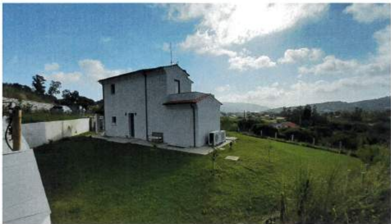
Descrizione: Vista prospetti Nord ed Ovest, fabbricato e sistemazione a giardino del lotto
