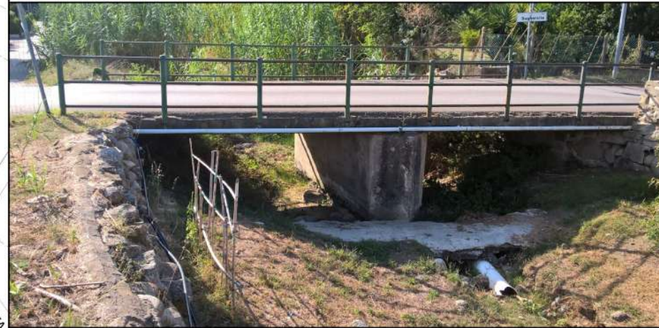
Foto 50 - attraversamento San Francesco via della Sugherella
