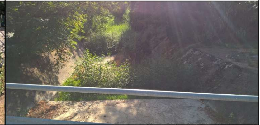
Foto 51 - valle attraversamento Bovalico via della Martinaccia
