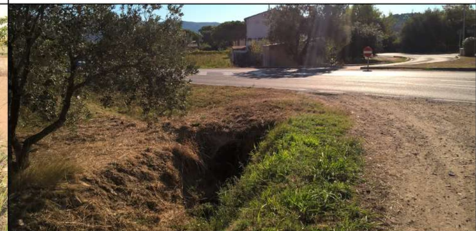
Foto 26 - attraversamento affluente Aiali sx via della Costa
