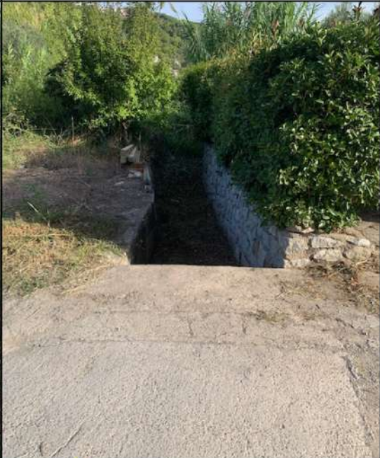
Foto 8 - tratto terminale Ciampone
