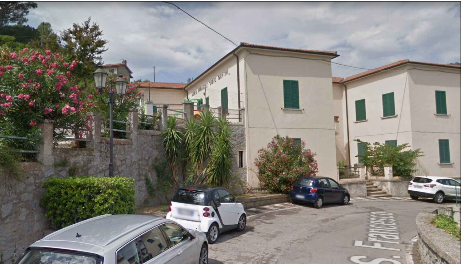
IDENTIFICAZIONE FABBRICATO OGGETTO DI INTERVENTO
