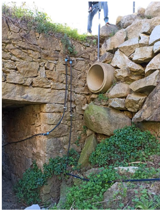
Figura 17: DN500 sull'Affluente destro, di recapito nel Canaletto
