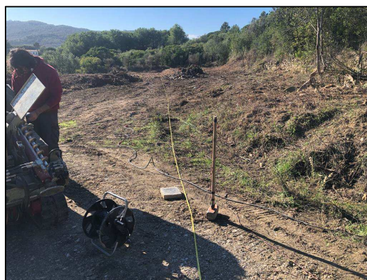
Stesa sismica MASW - Vista da G24
