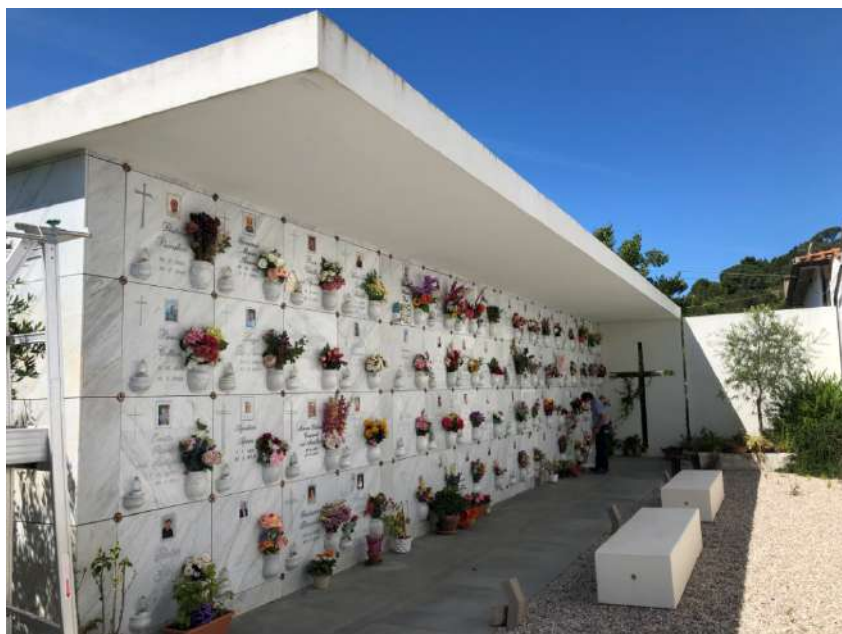
Interno recente ampliamento
