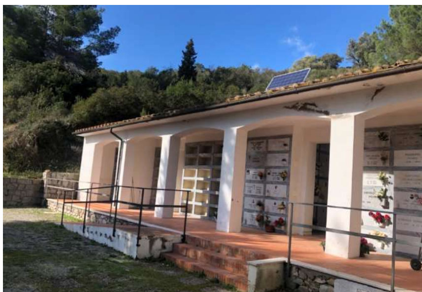
blocchi cimiteriali esistenti
