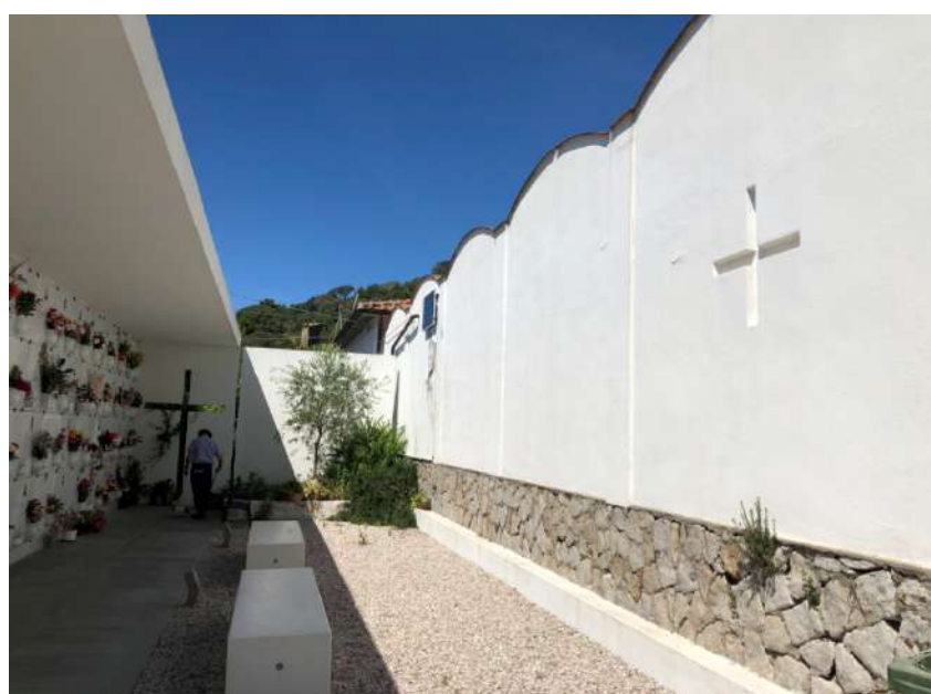
Interno recente ampliamento
