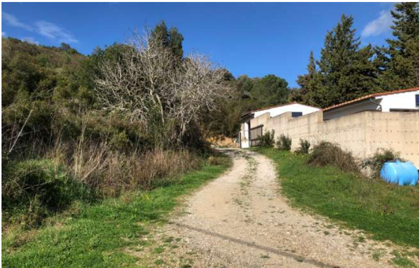
viale di servizio all'ingresso secondario
