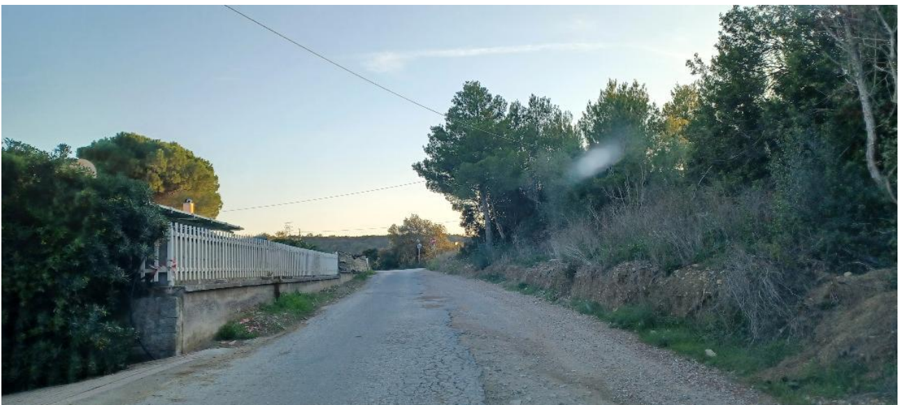
Via del Vallone vista 1
