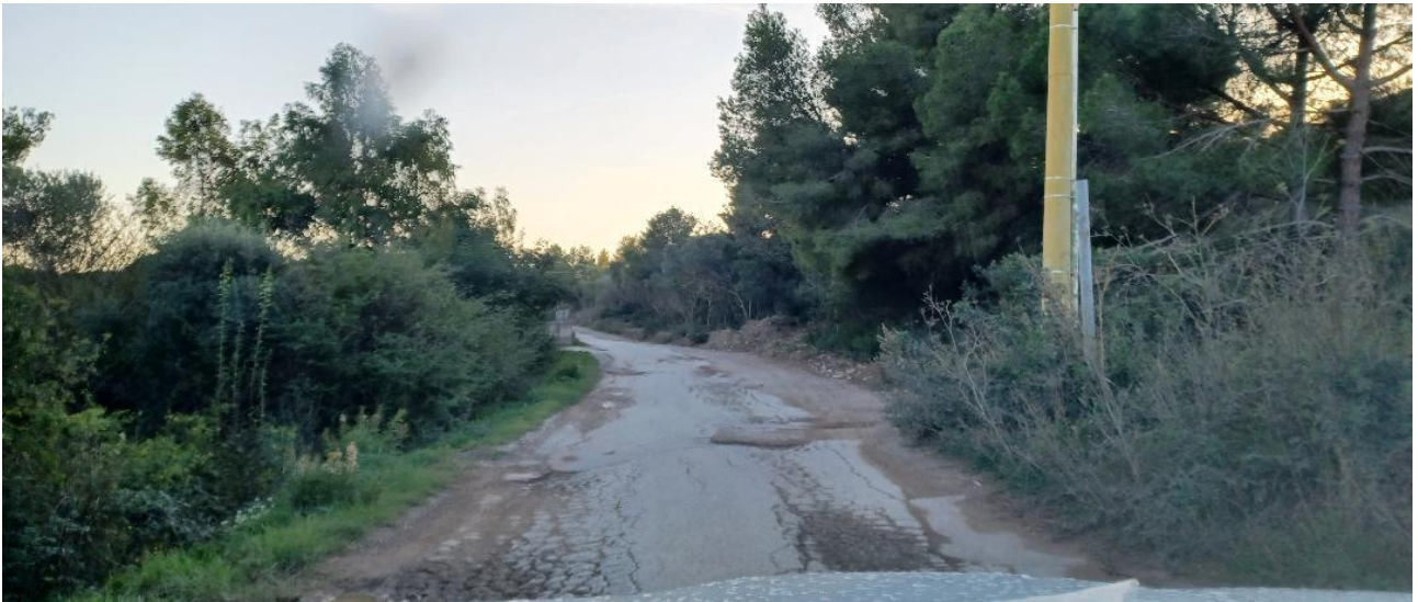
Via del Vallone vista 3
