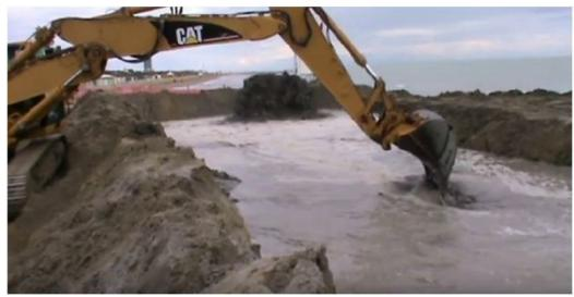
2. Trasporto dei sedimenti lungo la linea di costa sulla quale è previsto la riprofilatura con pala
