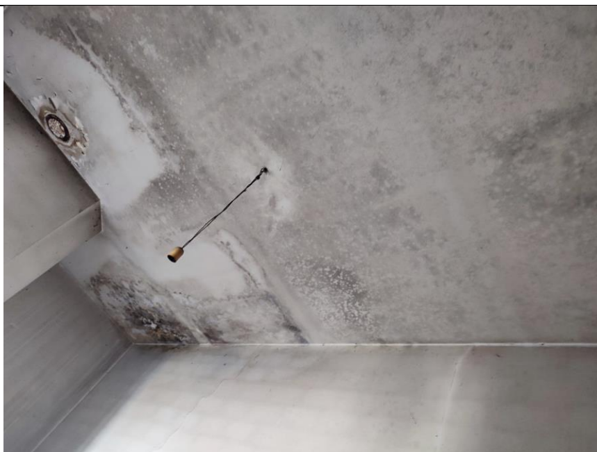
Vista n.05 Stato Attuale Interno
