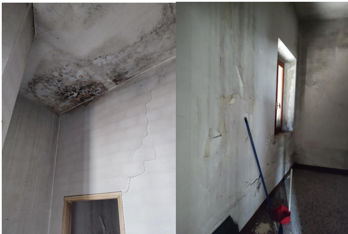
Vista n.04 Stato Attuale Interno
