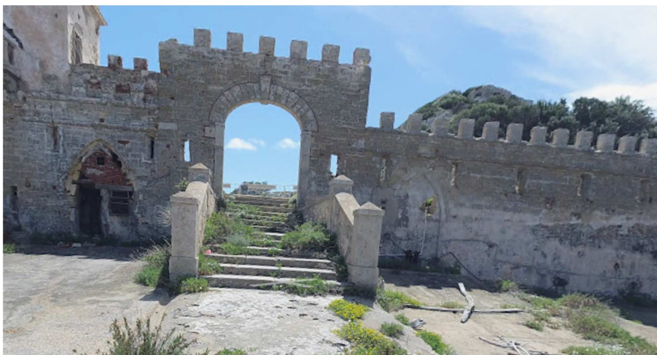
Scaletta di Accesso con le guardiole laterali (di cui una tamponata)
