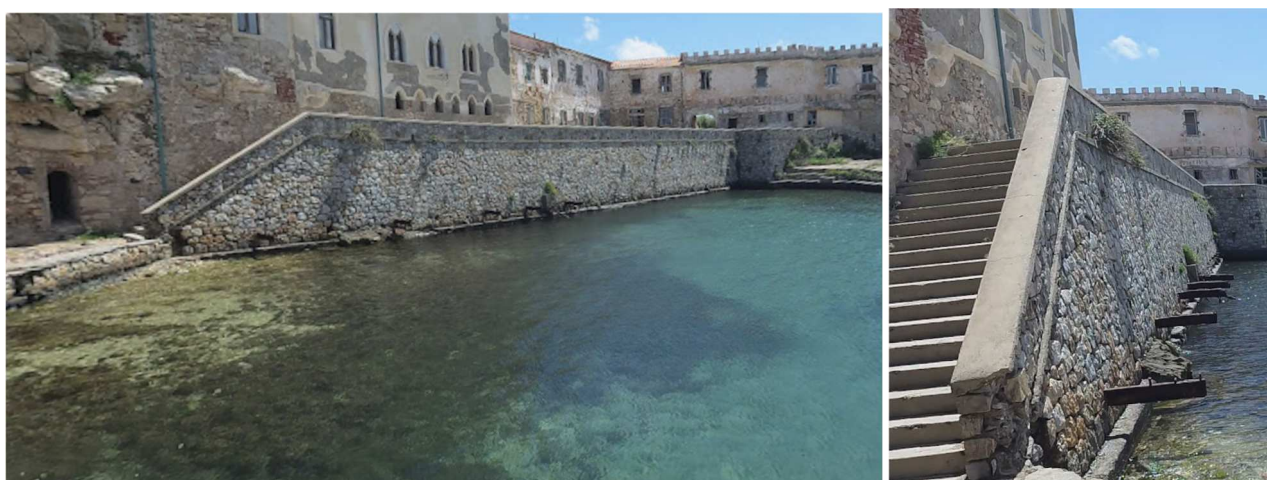
Muro di Sponda
